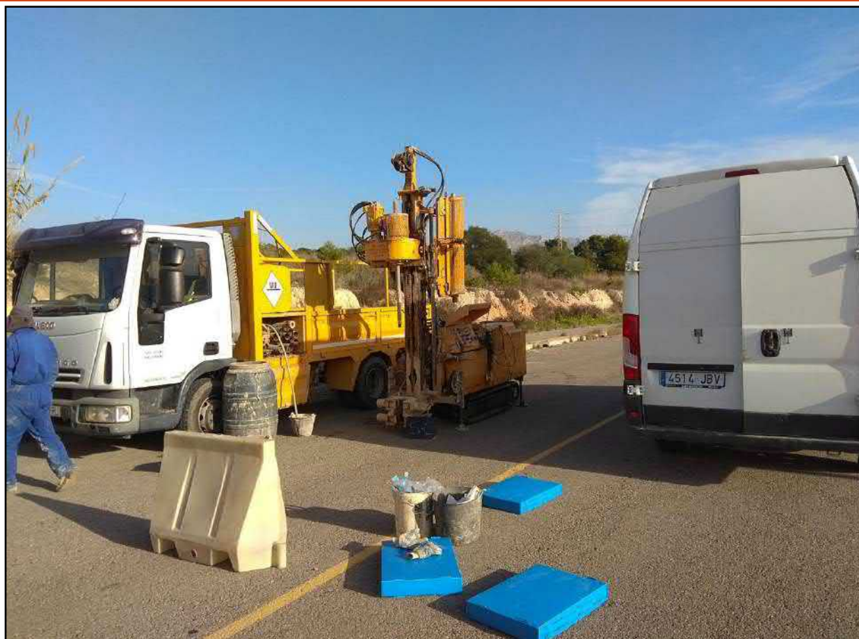
Figura 53: Posición máquina de sondeo en sondeo C.
