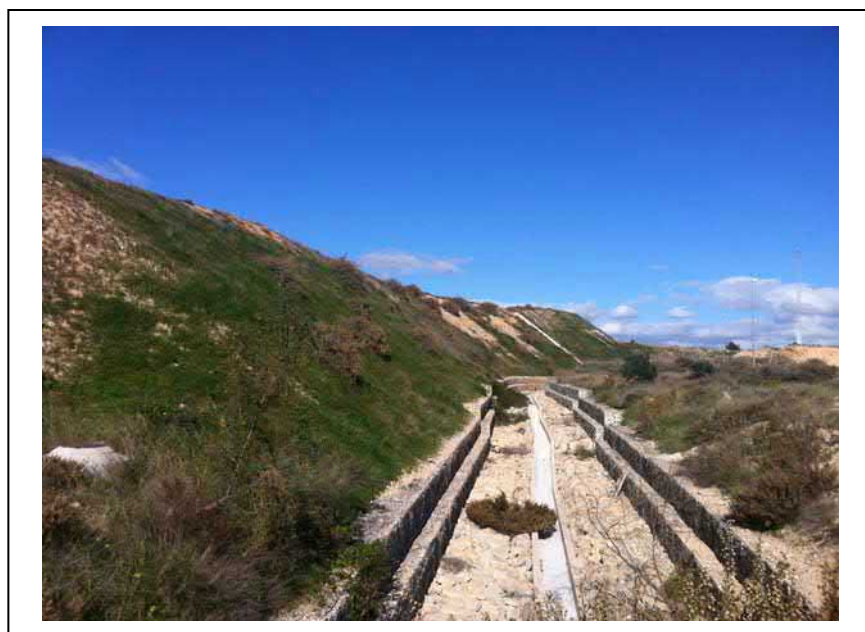
Fotografía 1. Vista del terraplén desde aguas abajo del barranco.
