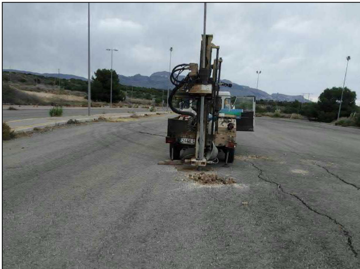
Figura 38: Posición máquina de sondeo en sondeo nº10.
