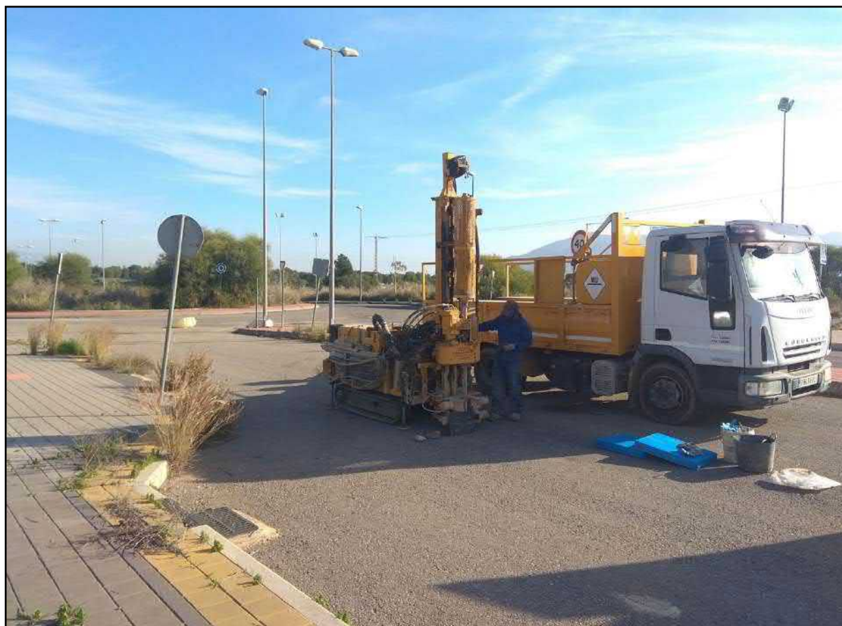
Figura 50: Posición máquina de sondeo en sondeo B.
