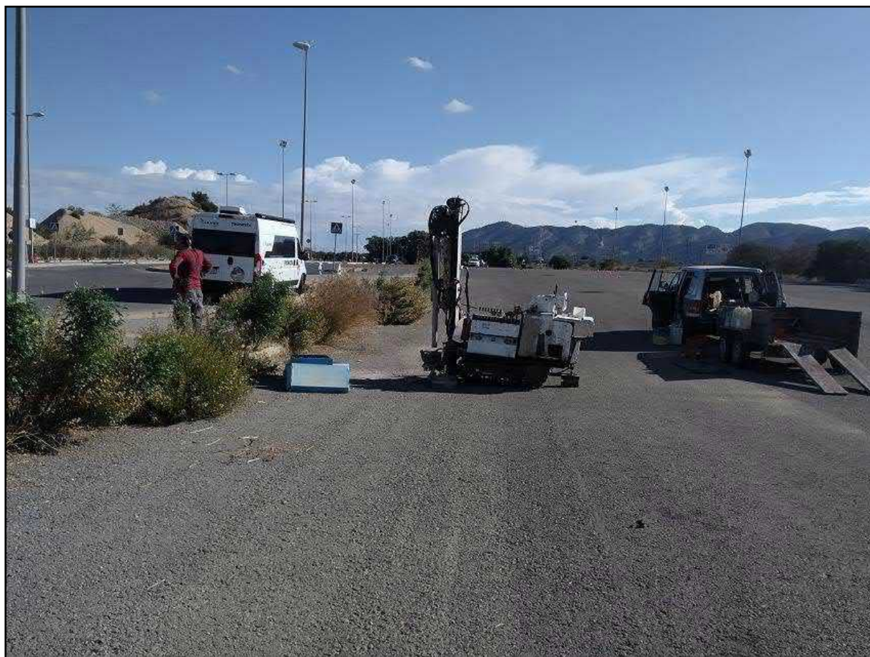
Figura 9: Posición máquina de sondeo en sondeo nº3.
