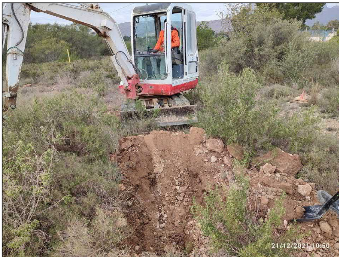
Figura 9: Cata 3 realizada en el terreno. Profundidad 0,40 m.
