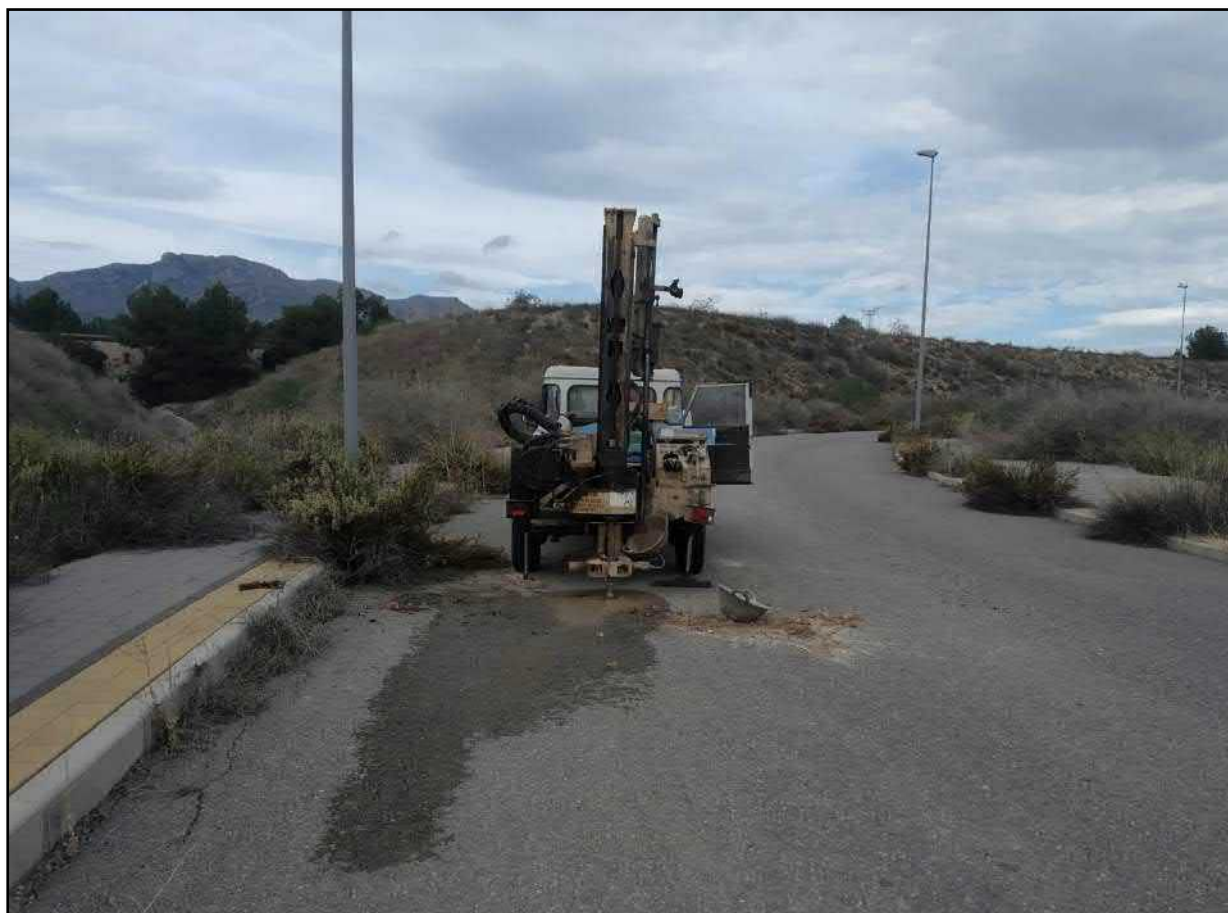
Figura 13: Posición máquina de sondeo en sondeo nº4.
