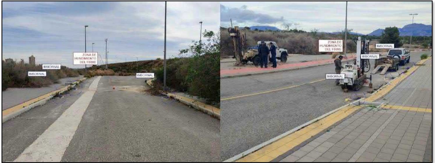
Figura 8: Elementos de drenaje longitudinal de los viales situados en las zonas con mayor hundimiento.
