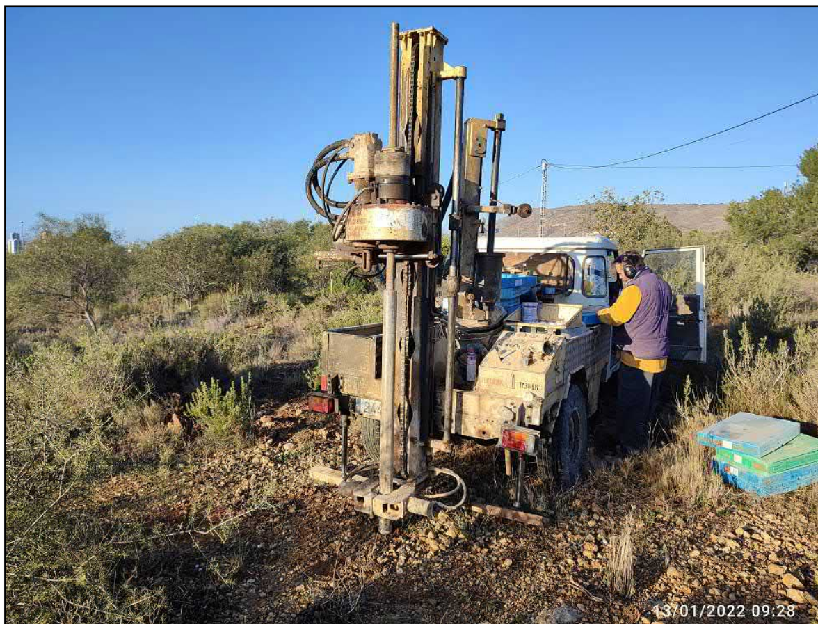
Figura 1: Posicionamiento máquina de sondeos a rotación 1.
