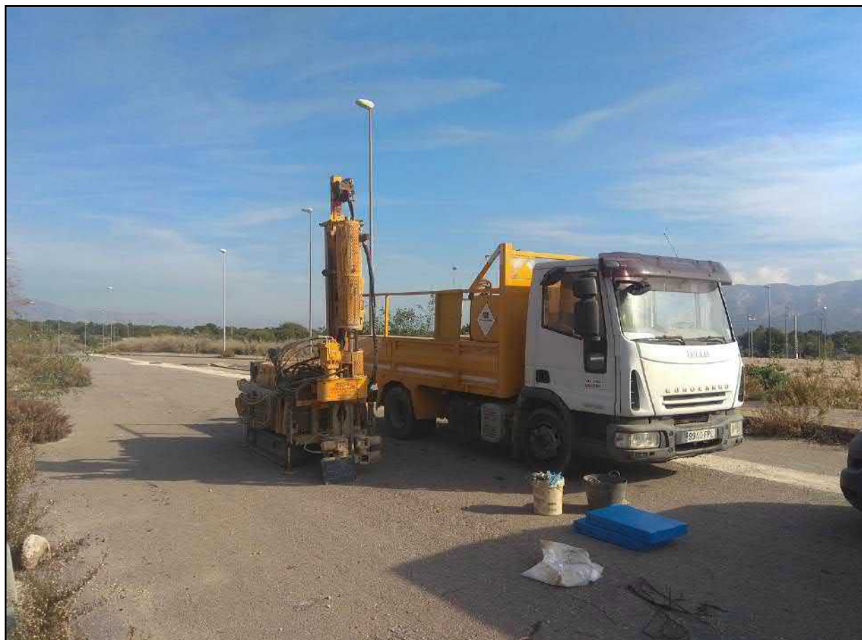
Figura 56: Posición máquina de sondeo en sondeo D.
