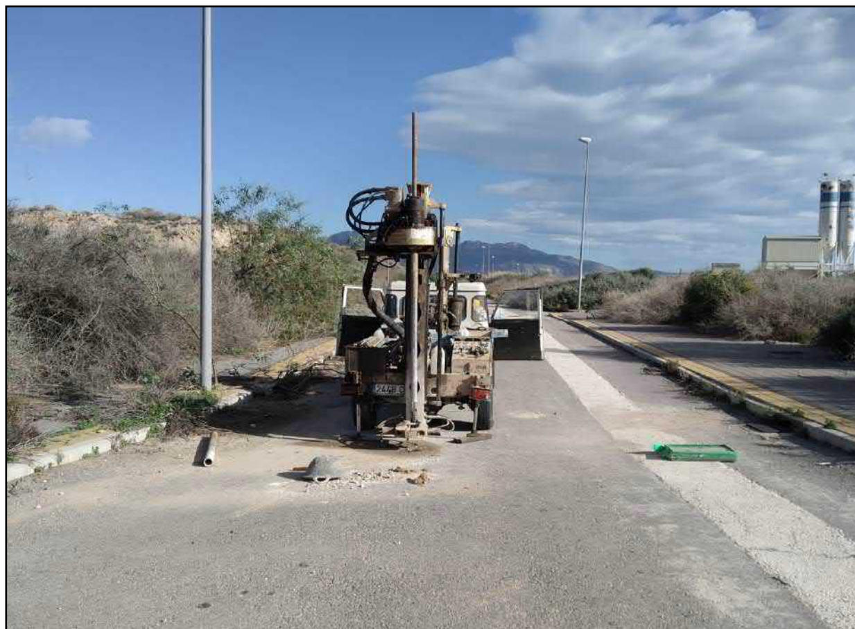
Figura 22: Posición máquina de sondeo en sondeo nº6.
